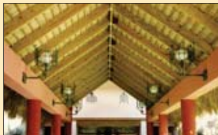
El Pino Amarillo es una especie de madera adecuada para la ejecución de entramados y elementos estructurales.
